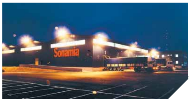
C'est à Saint-Hilaire-de-Loulay que l'entreprise Sonamia a décidé de s'installer. Les travaux débuteront en 2013.
