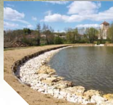
Les berges de l'étang de Saint-Martin-Lars-en-Sainte-Hermine ont été refaites grâce à des tapis de végétalisation en natte coco.
