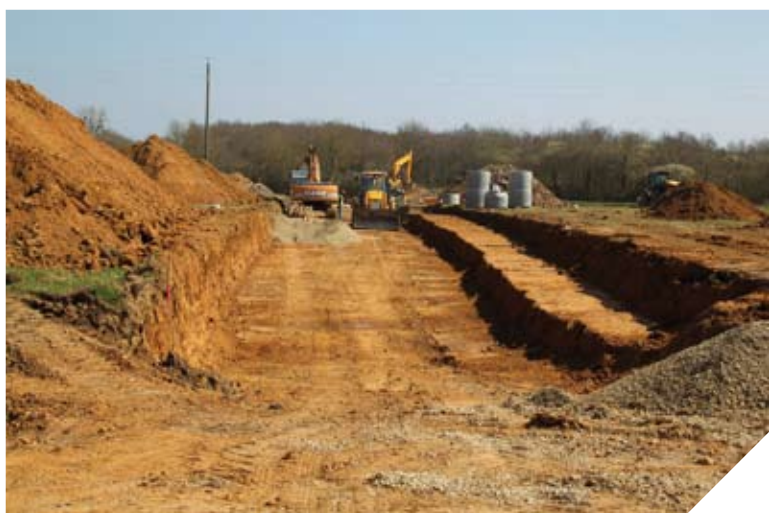
Parmi les trois grandes innovations de ce Vendée Écopôle, il y a la tranchée unique pour le passage des différents réseaux.
