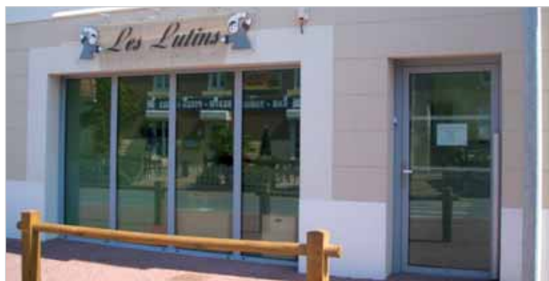
Situé en centre-bourg, le complexe comprend deux commerces, quatre logements et une micro-crèche.
