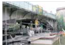
Les travaux de restauration du pont d'Apremont sont déroulés d'octobre 2010 à juin 2011.
