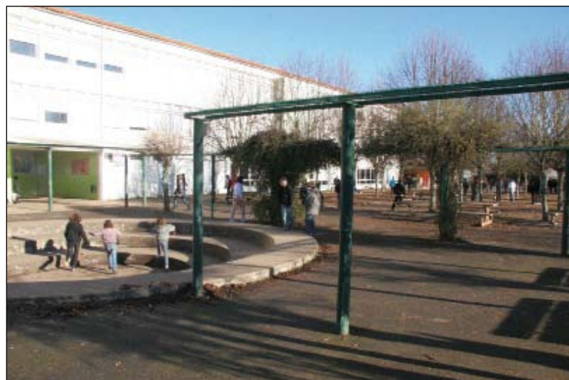
Les travaux permettront de restructurer le collège du Marais Poitevin.
