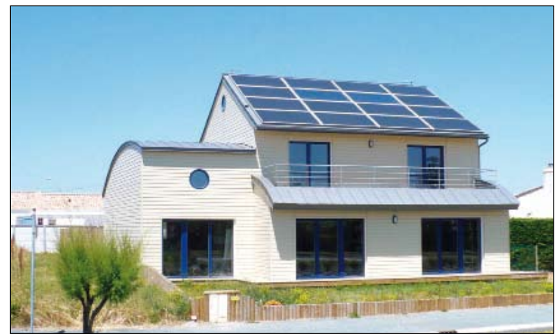
Situé sur l'avenue Ile de Riez, le bureau d'études Alliance Soleil allie esthétique et performance.
