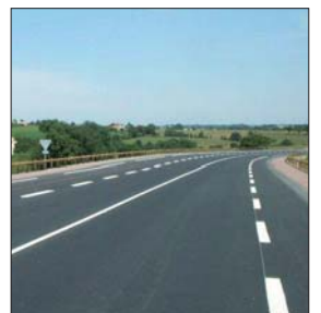
Un nouveau contournement à Sainte-Flaive-des-Loups est ouvert à la circulation.
