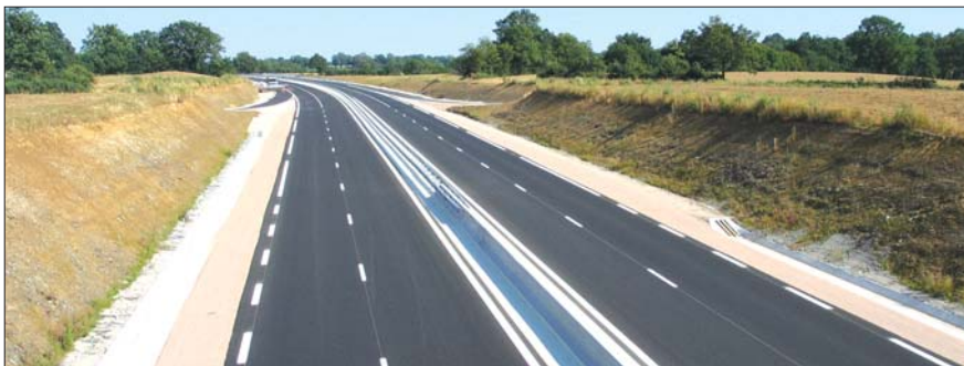
Les nouvelles voies apporteront fluidité et sécurité.
