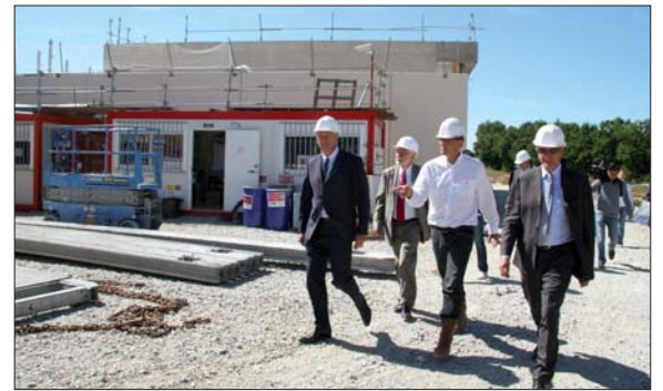
Philippe de Villiers, Président du Conseil général et Michel-Jean Floc'h, inspecteur d'académie, ont visité le futur chantier du collège d'Aubigny. Ici, aux côtés de l'architecte, Frédéric Fonteneau.
