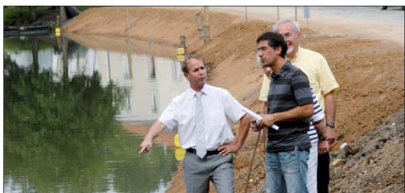
Au lieu-dit « Jard », Jean Tallineau accompagné des maires de Benet et du Mazeau, font un état des lieux du chantier de restauration des berges de la Sèvre Niortaise.
