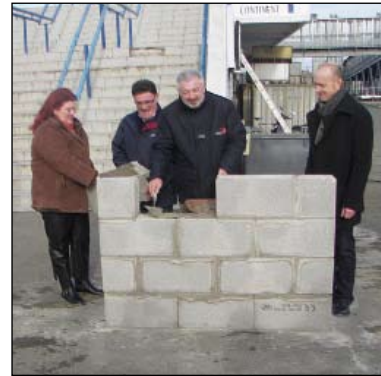
Les travaux de la gare maritime de Port Joinville, à l'île d'Yeu, ont débuté.
