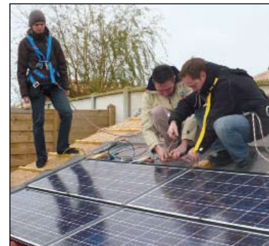
Les artisans apprennent à poser des panneaux solaires.
