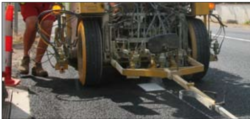
La peinture à l'eau, expérimentée sur la RD 38.
