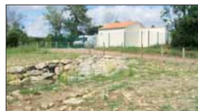
Station de pompage sur le Lay.
