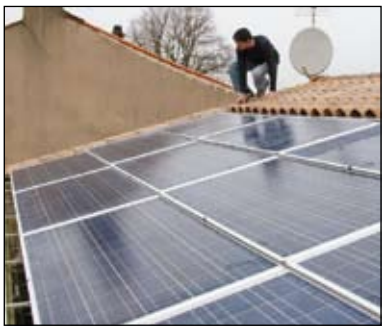
Un nouveau site Internet facilite les démarches administratives pour le raccordement.
