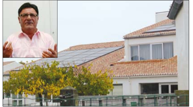
Henri Turbé se félicite de la mise en place d'une centrale photovoltaïque sur le collège de l'île d'Yeu.
