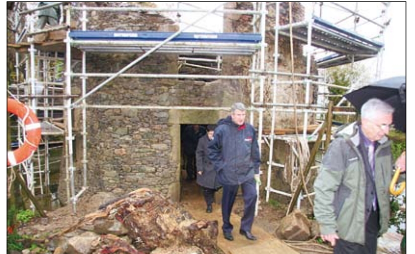
Visite du chantier du site de la Sénardière, plusieurs siècles d'histoire réunis en un même lieu.
