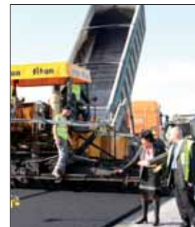
Veronique Besse, conseillère générale des Herbiers mesure l'étendue des travaux réalisés.
