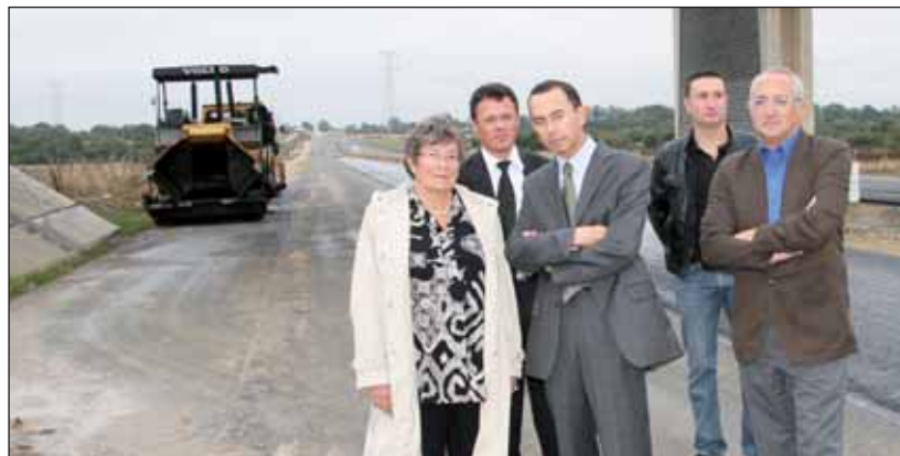
Plus que quelques travaux de finition avant l'ouverture de la 2x2 voies entre St-Christophe et Maché.
