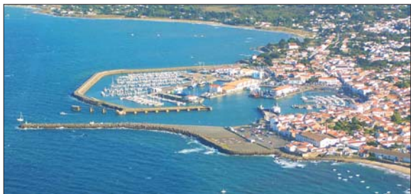
Les travaux d'enfouissement des lignes électriques s'accroissent à l'île d'Yeu.
