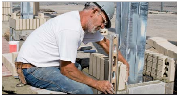
Chantiers départementaux et aides d'accès à la propriété devraient aider les entrepreneurs du bâtiment.
