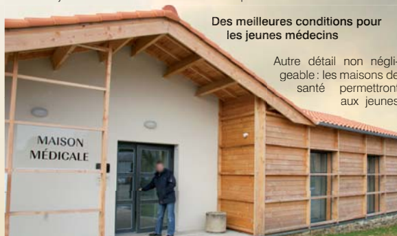
La maison de santé à Saint-André-Treize-Voies a ouvert ses portes en décembre dernier.
