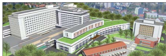
Les travaux du CHD ont commencé par la construction du futur centre de réanimation.
