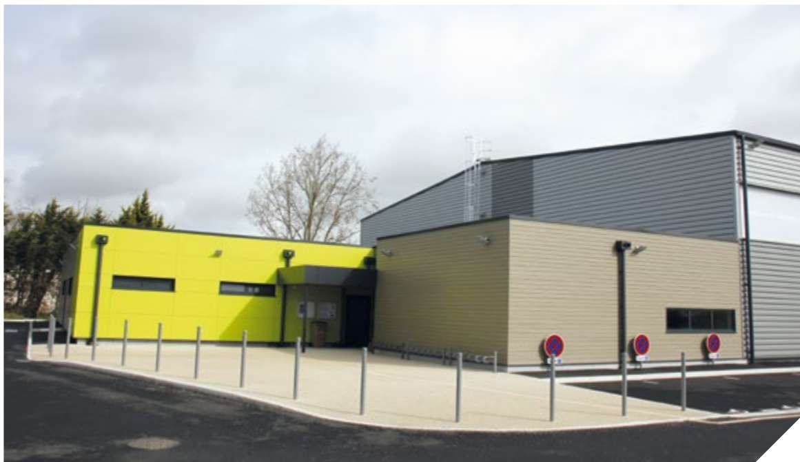
Réalisé dans le cadre du CVT de Challans, le complexe sportif de Sallertaine est un exemple concret des projets attendus par les communes.
