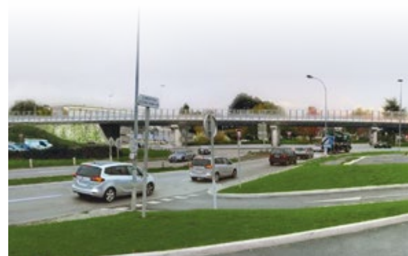
Vue du futur viaduc, fin 2020, en arrivant à La Roche depuis Nantes.
