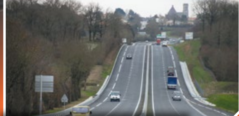
Elle est ouverte à la circulation depuis le 5 décembre. La nouvelle section en 2x2 Aizenay-La Vie représente un maillon de l'axe structurant entre Chantonnay et Challans. Classée d'intérêt régional, cette route situera Aizenay à environ une heure de Saint-Nazaire.
