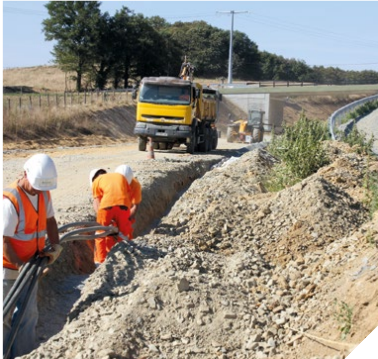
Les ouvriers s'activent sur plusieurs kilomètres. Ce contournement de 7 km est très attendu notamment par les usagers du secteur Pouzaugais fréquentant quotidiennement l'axe.
