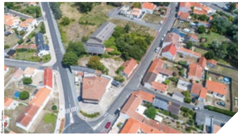
À Saint-Jean-de-Monts, l'EPF de la Vendée a accompagné la commune pour les travaux de dépollution de ce site.
