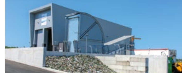
Le nouveau centre permettra de traiter 3 800 tonnes d'ordures ménagères par an.
