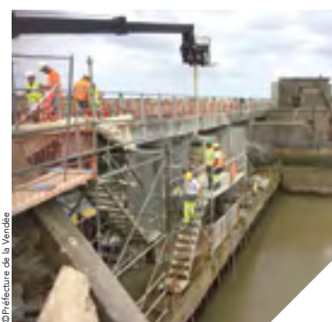
Le chantier durera jusqu'à l'été 2018.
