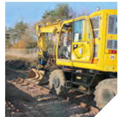
22 km de voie ferrée sont restaurés.
