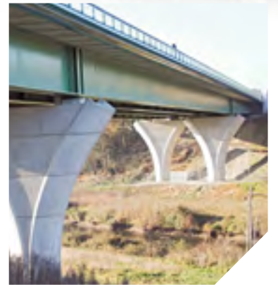
Le viaduc du Petit Lay.
