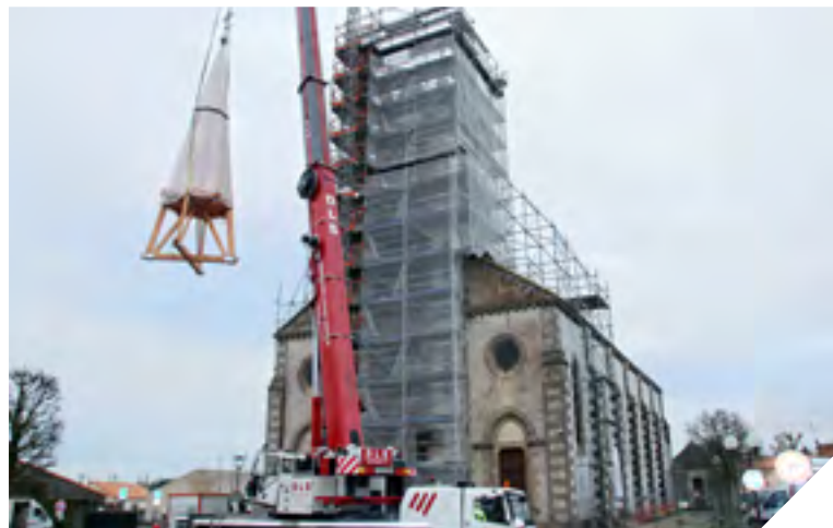
Une matinée entière fut nécessaire pour monter la nouvelle flèche de l'église.
