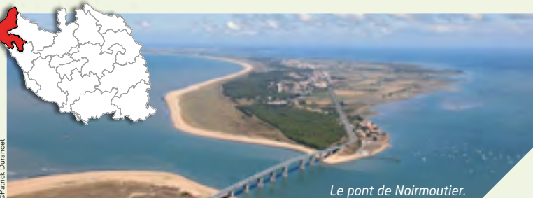
Le pont de Noirmoutier.
