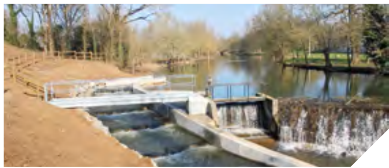
L'ouvrage s'intègre parfaitement dans le paysage.
