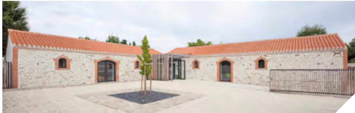
Prix de la réhabilitation pour la médiathèque de Saint-Gervais (AM Architecture et intérieur et Martial architecte urbaniste). Situés au cœur du bourg, ces anciens haras communaux ont fait l'objet d'un projet de réhabilitation et d'extension.
