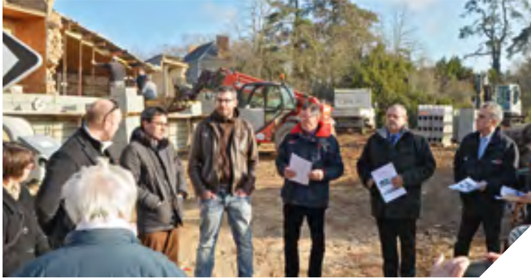
Les élus, dont les conseillers départementaux Marcel Gauducheau et Pierre Berthomé, ont visité le chantier des aménagements du centre bourg de Moutiers-les-Mauxfaits.
