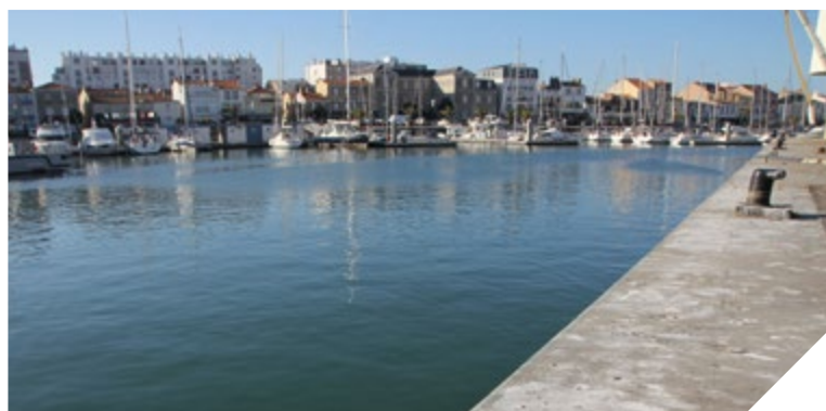
Le nouveau quai de la jauge, un atout pour le port des Sables.
