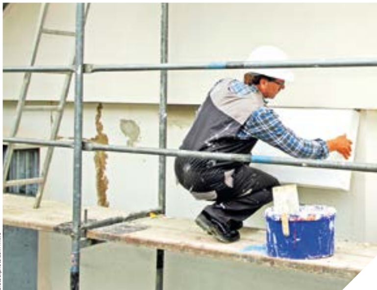
En 2015, 1 000 ménages vendéens ont bénéficié d'aides pour des travaux dans leur logement. Au total, 17 millions d'euros de travaux ont été réalisés dans ce cadre.
