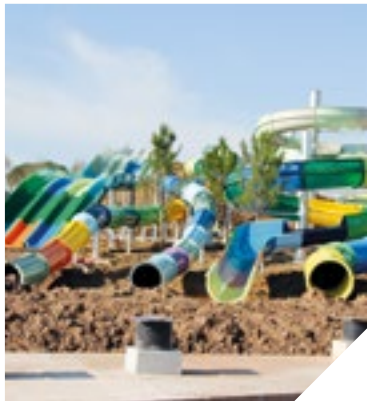
Plus de 200 personnes seront amenées à travailler sur le chantier.
