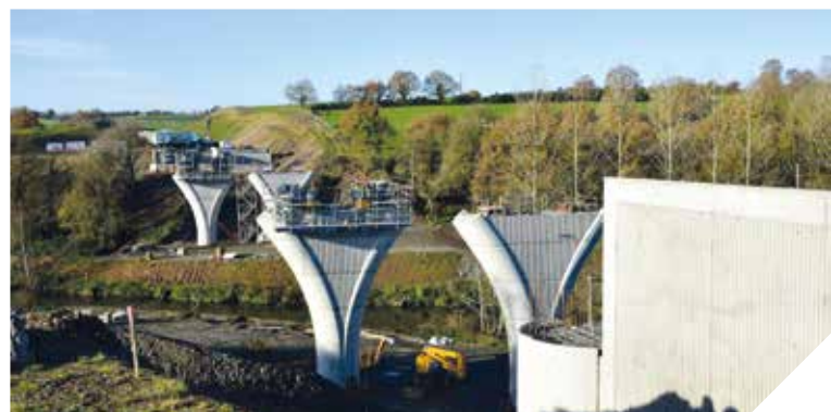
Les piles du pont sont en cours de réalisation.
