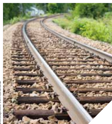
La ligne Nantes-Bordeaux nécessite d'importants travaux.
