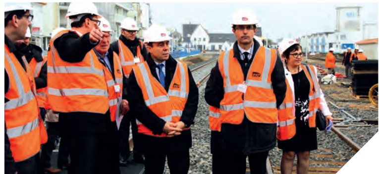
Visite de chantier à St Gilles-Croix-de-Vie avec les conseillers départementaux Alain Leboeuf et Laurent Boudelier.
