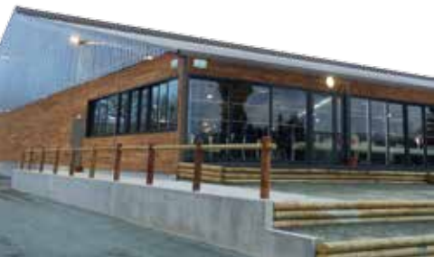
La toiture du parc est entièrement recouverte de panneaux photovoltaïques.
