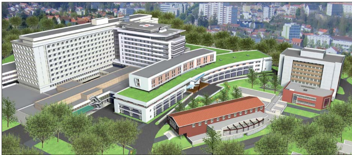
Les travaux prévoient notamment une extension des parkings et la création d'une hélisation (au fond sur l'image).
