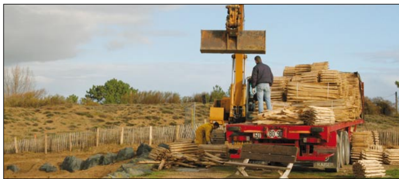
Les travaux ont permis de réensabler les plages tout en respectant les dunes de la baie.
