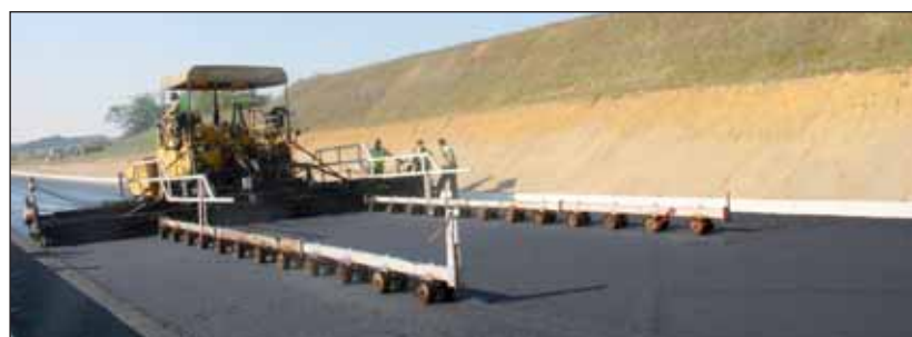
La première tranche du contournement est presque terminée.
