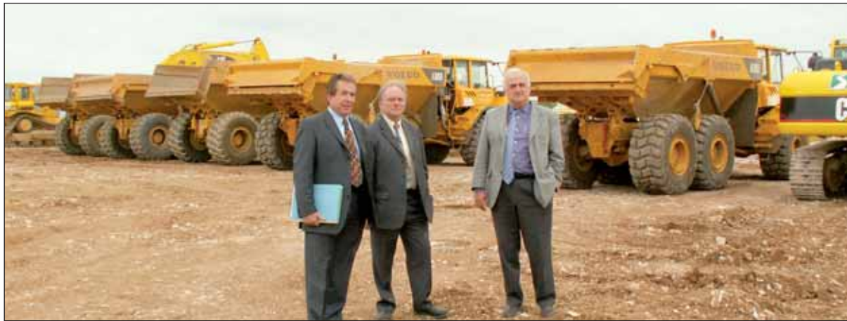
Joël Sarlot est venu à Oulmes se rendre compte de l'état d'avancée du chantier.
