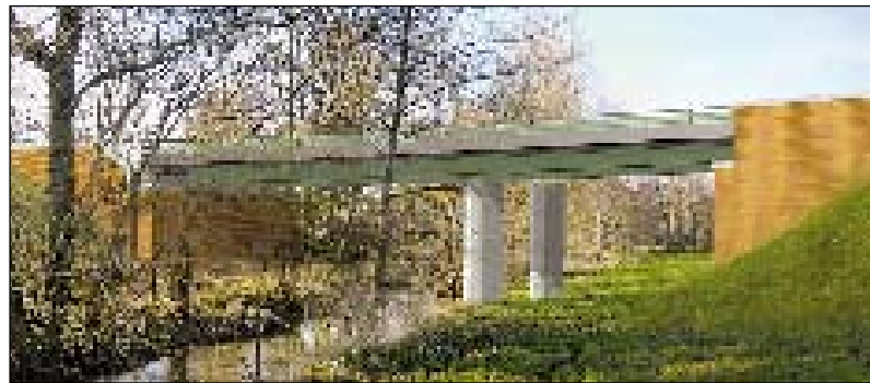
Le pont qui surplombe le Ruth, en cours de construction.
