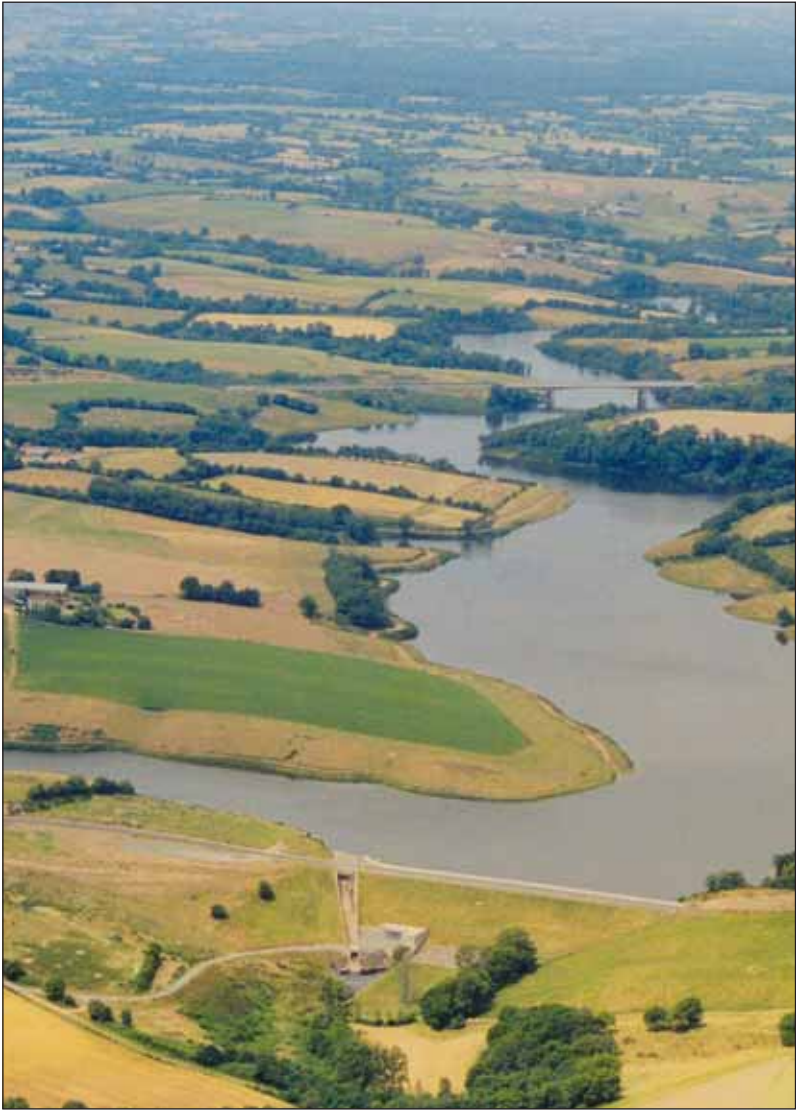
Le barrage de La Vouraie sera ouvert au public le 26 mars prochain.
