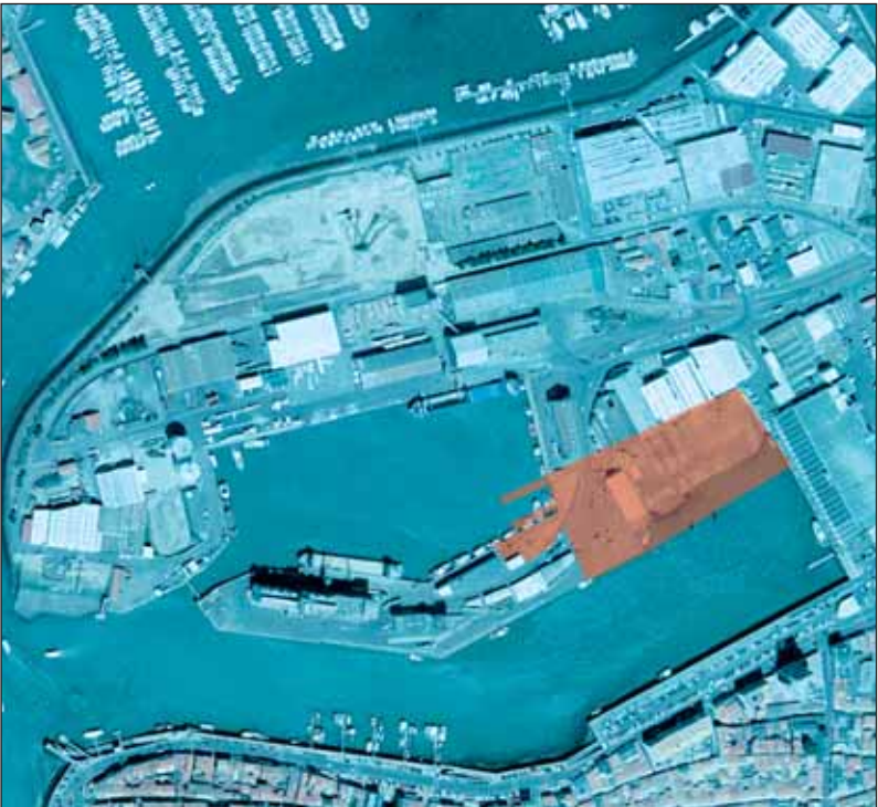
L'élévateur et la plate-forme occuperont une place stratégique sur le port.
