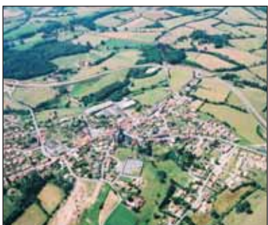
Le contournement, comme ici aux Epesses, permettra de limiter le trafic en centre-ville.
