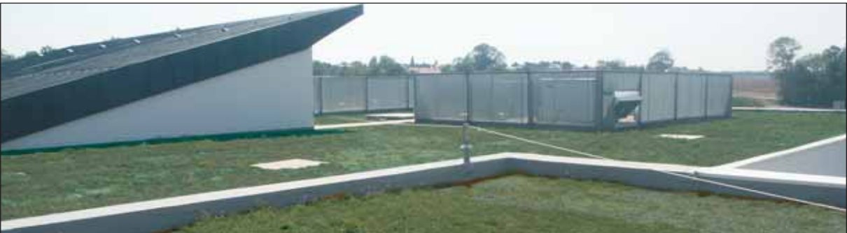
Les toitures du collège sont revêtues d'une couche végétalisée qui permet d'intégrer le bâtiment dans son environnement.
