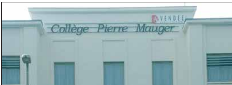
Les collèges Beausire et Herriot notamment vont bénéficier d'une modernisation complète du même type que celle qui vient de s'achever au collège Pierre Mauger des Sables d'Olonne.
