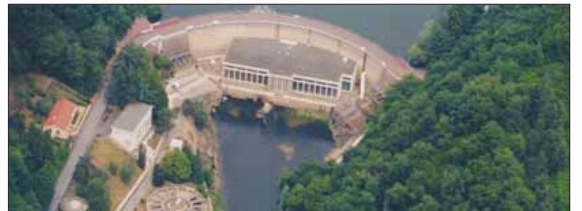
Avec l'interconnexion à Angle-Guignard, les 40 communes du secteur de Fontenay ne sont plus à la merci d'une pollution du barrage de Mervent.
