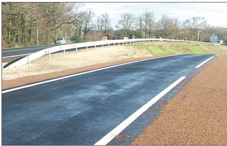
La voie nouvelle Longève-Sérigné-Pissotte sera totalement terminée en 2006.
