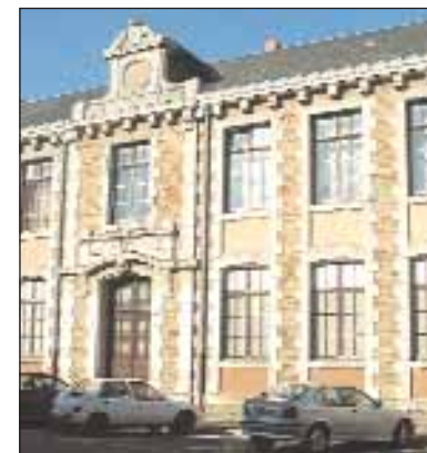
Plus de 3 500 m 2 ont été entièrement rénovés.
