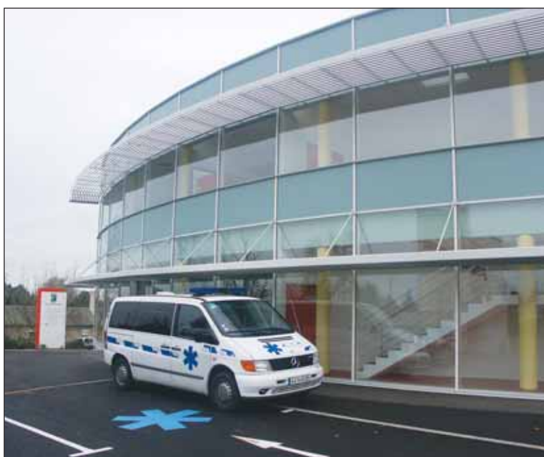
Le nouveau bâtiment accueille la médecine générale, les urgences et le plateau technique.
