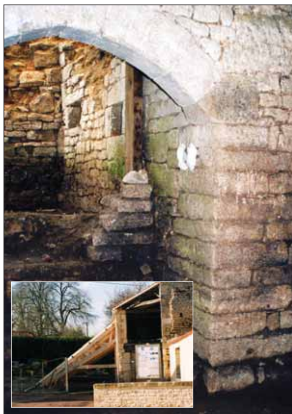
Les caves étaient dissimulées sous le hangar communal de Xanton-Chassenon.
