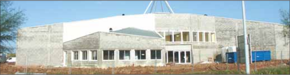
Le nouveau cinéma utilise les dernières technologies en matière de son et de lumière.
