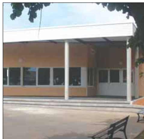
Le nouveau bâtiment libère des espaces pour l'aménagement d'un foyer des élèves.
