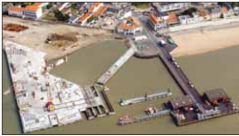
La nouvelle salle d'embarquement du port de Fromentine est en plein chantier. Un prélude à la modernisation du port, qui sera achevée en 2005.
